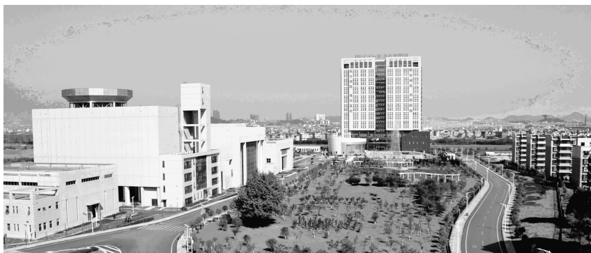
科研区一角——直升机研发平台
